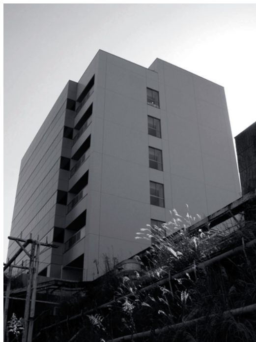
▲総合実験研究棟外観
